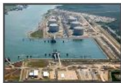
LNG Golden Pass Terminal
