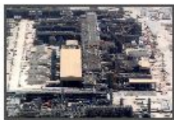
LNG RasGas Train 7
